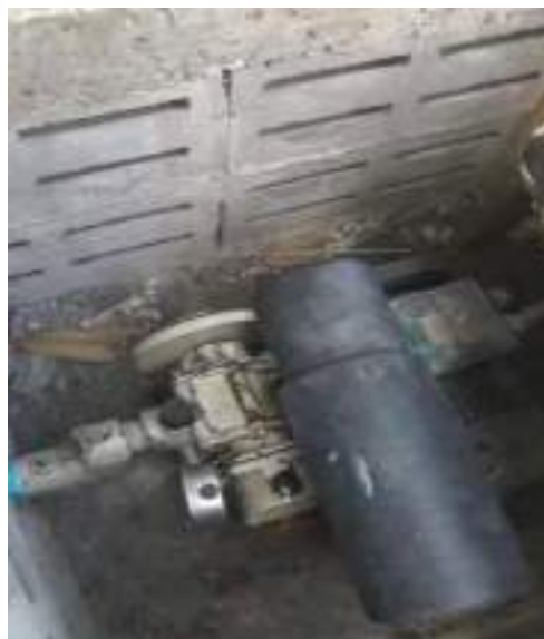
รูปที่ 7 ระบบบำบัด/ปั๊มเติมอากาศ
